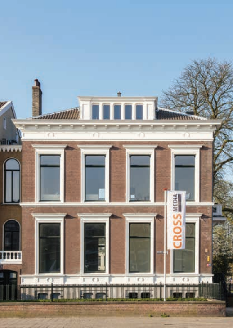
Voorgevel na restauratie
